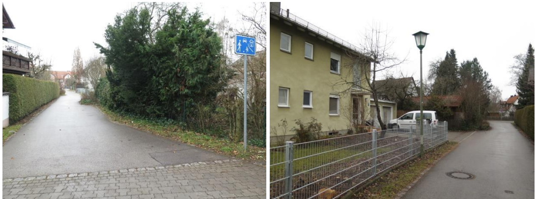
Abb. 6 Grundstraße Richtung Süden; dto. Richtung Norden, Nachbarbebauung Hs. Nr. 43
