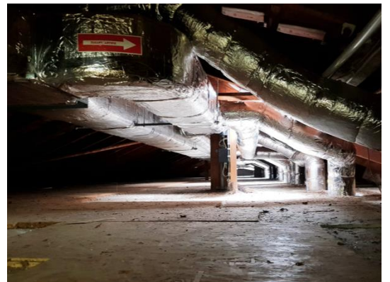
keine Lücken und Öffnungen zwischen Dach- und Firstziegeln und Dachansatz
