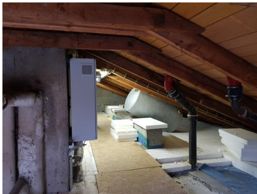
Dachboden mit Holzgebälk
