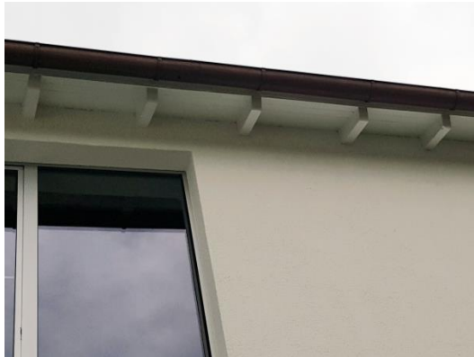
Dachüberstände mit Holzbalken
