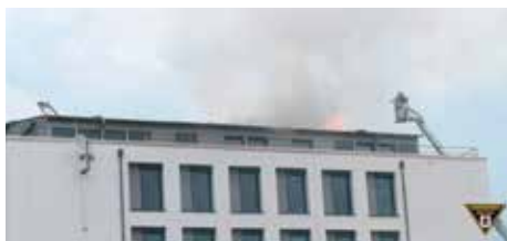
Dachstuhlbrand in München (Foto: BF München)
