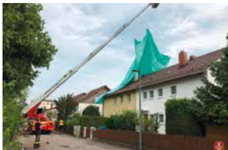
Montage eines Notdaches mit unserer Drehleiter (Foto: FF Neuried)
