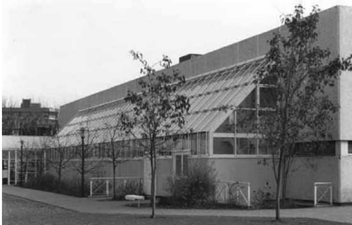
Die Mehrzweckhalle mit neuem Anbau nach dem Umbau von 1988 (Foto: K. Chwalczyk)
