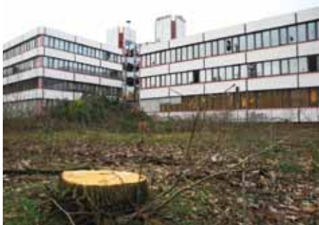
Baumfällarbeiten auf dem ehemaligen Hettlage-Gelände (Foto: Christiane Unger)
