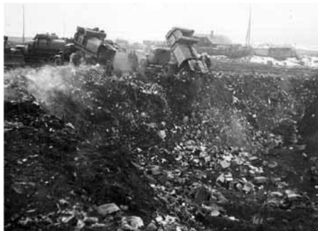
Auffüllung der Gruben verwendet. Die Hausunratabfuhr München 1950 bei der Arbeit in Neuried (Grube Ostseite)
