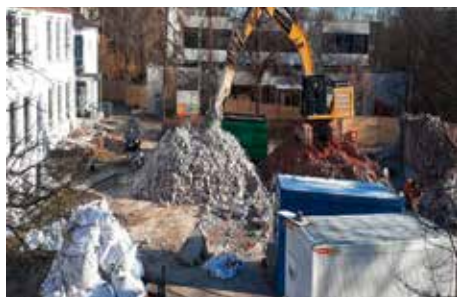
Ein Bagger zerkleinert die Betontrümmer des Feuerwehrgerätehauses (6. Februar 2020)
