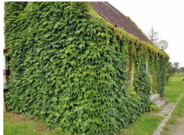
Durch das Luftpolster zwischen Fassade und Blättern ist es im Inneren dieses „grünen“ Hauses im Sommer angenehm temperiert.
