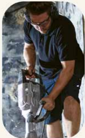
Kernsanierung und Instandhaltung
