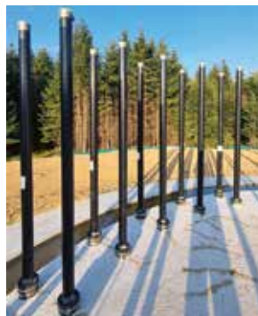
(Foto oben): Dr. Dieter Maier beim neuen Umspannwerk; Fundament eines der Windräder
